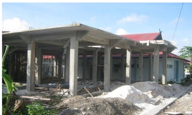
Gambar 4.3 : Pembangunan Gedung Depo Arsip
