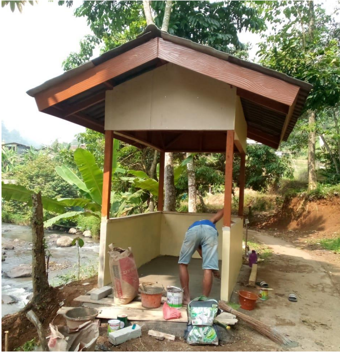
Gambar 4. Pembangunan Pos Jaga
