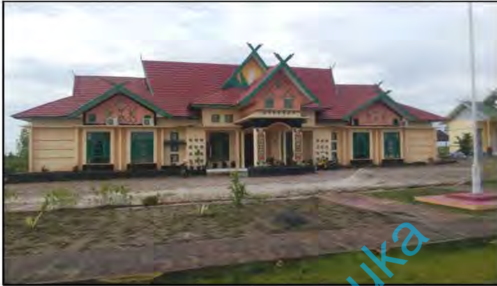
Gambar 4.9 Tampak Bahwa Gedung Kantor Penanaman Modal dan Pelayanan Perijinan Dibangun Permanen dan Dalam Kondisi Baik
