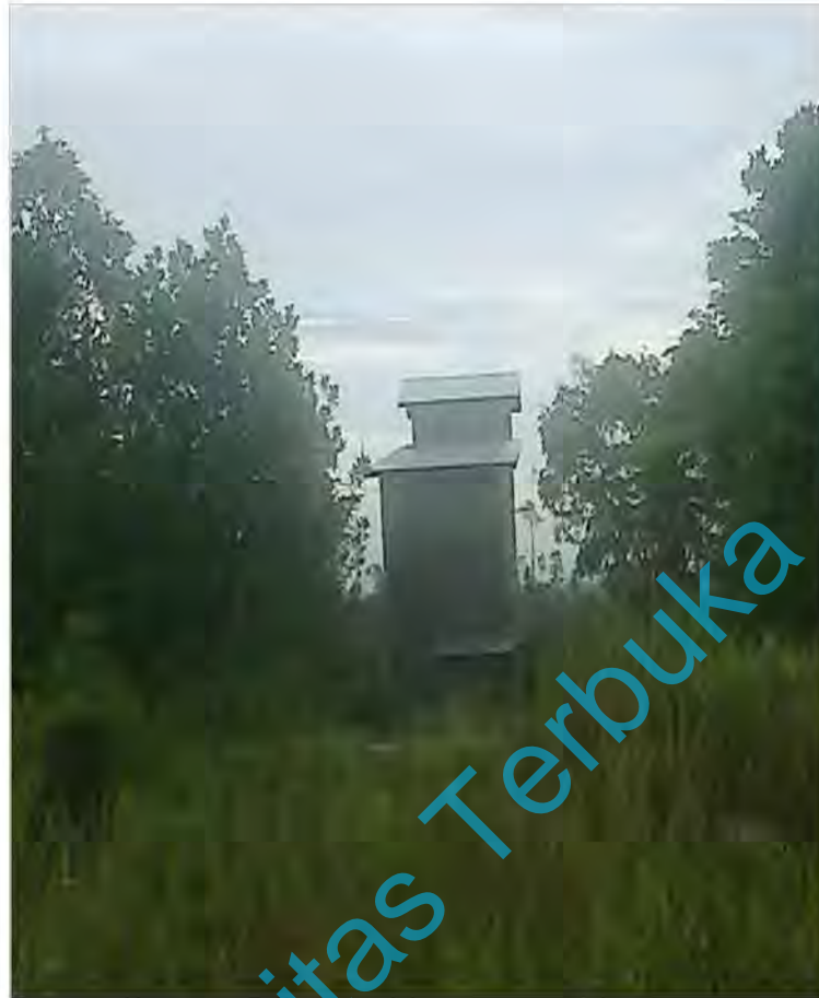
Gambar 4.3 Salah Satu Bangunan Rumah Burung Walet yang Baru Selesai Dibangun Awal Tahun 2013 di Jalan Margasari, Desa Natai Sedawak dan Tidak Memiliki Ijin Usaha Budidaya Sarang Burung Walet
