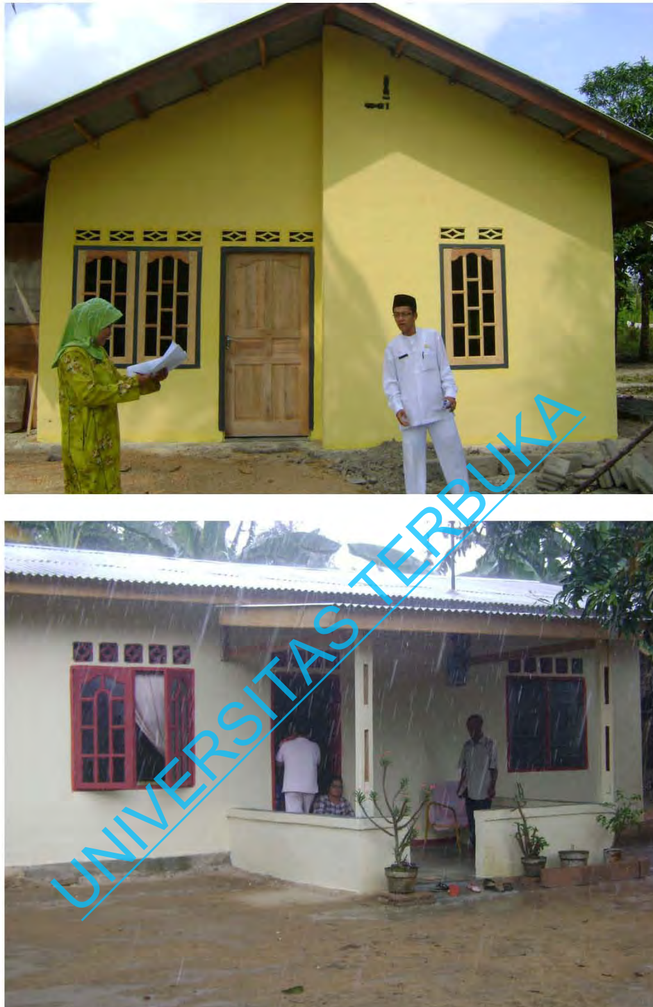
Gambar 4.4. Beberapa unit rumah setelah rehabilitasi - hasil implementasi Program Bantuan RS-RTLH di Kabupaten Bintan
