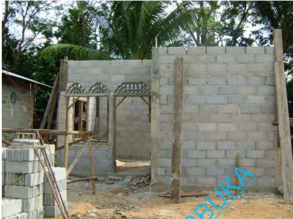
Gambar 4.3a. Tahapan RS-RTLH - pemasangan dinding rumah. (Sumber : Dokumentasi Dinas Sosial Kabupaten Bintan, 2011)
