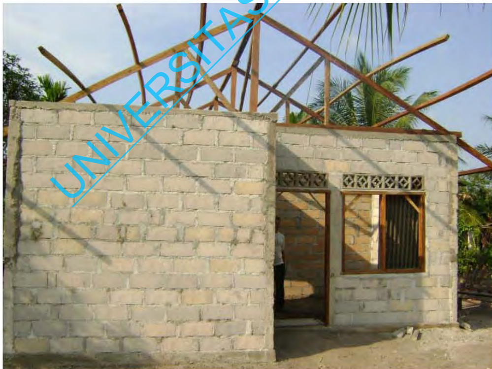
Gambar 4.3b. Tahapan RS-RTLH - pemasangan rangka atap rumah. (Sumber : Dokumentasi Dinas Sosial Kabupaten Bintan, 2011)
