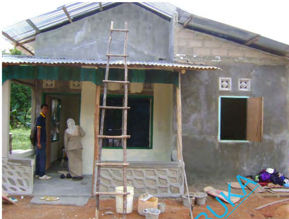
Gambar 4.3c. Tahapan RS-RTLH - plester dinding dan finishing rumah. (Sumber : Dokumentasi Dinas Sosial Kabupaten Bintan, 2011)
