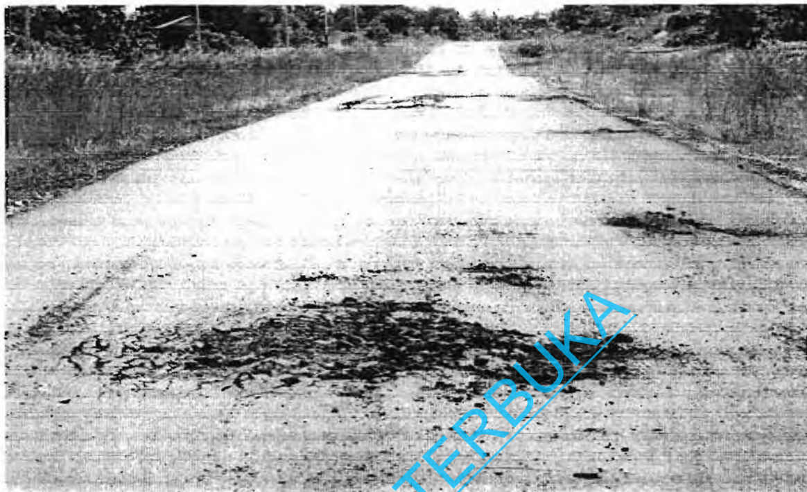
Gambar kondisi jalan lingkar menuju RSUD Nunukan dibangun tahun 2012
