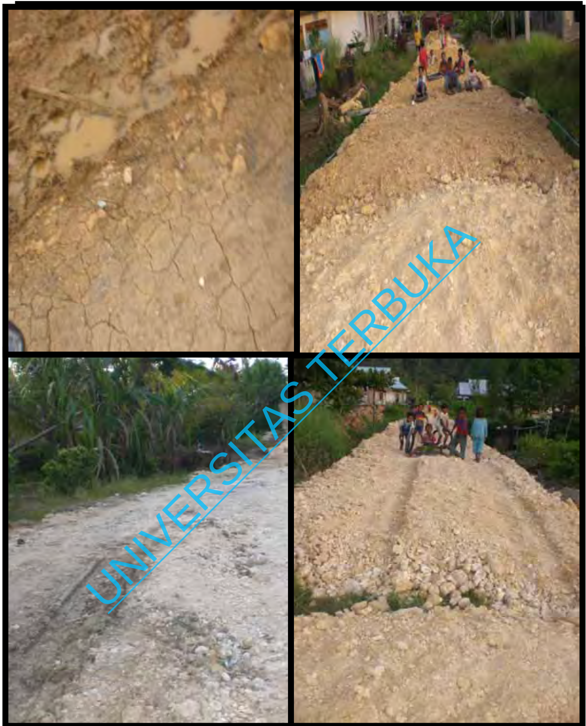
Hasil Program P2KP berupa pengerasan jalan yang kondisinya sudah rusak dan tidak layak untuk dilalui kendaraan
