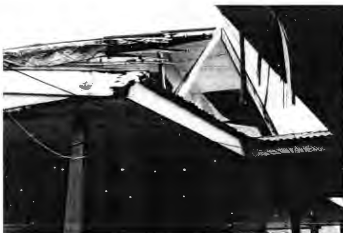
Gambar 17. Beberapa Bagian Fisik Gedung yang Sudah Rusak Berat
