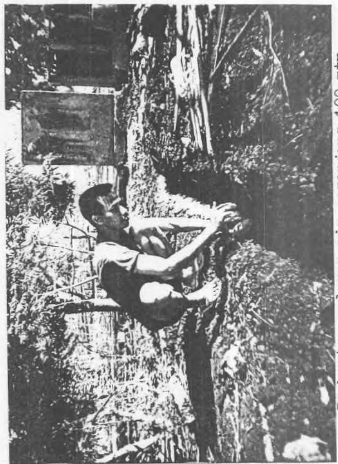
Pembuatan saluran air sepanjang 100 mtr
