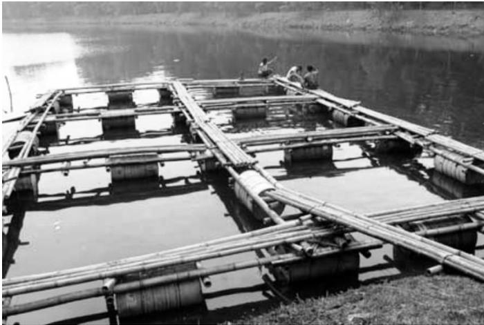
Gambar 1.11. KJA yang Menggunakan Pelampung dan Bambu
