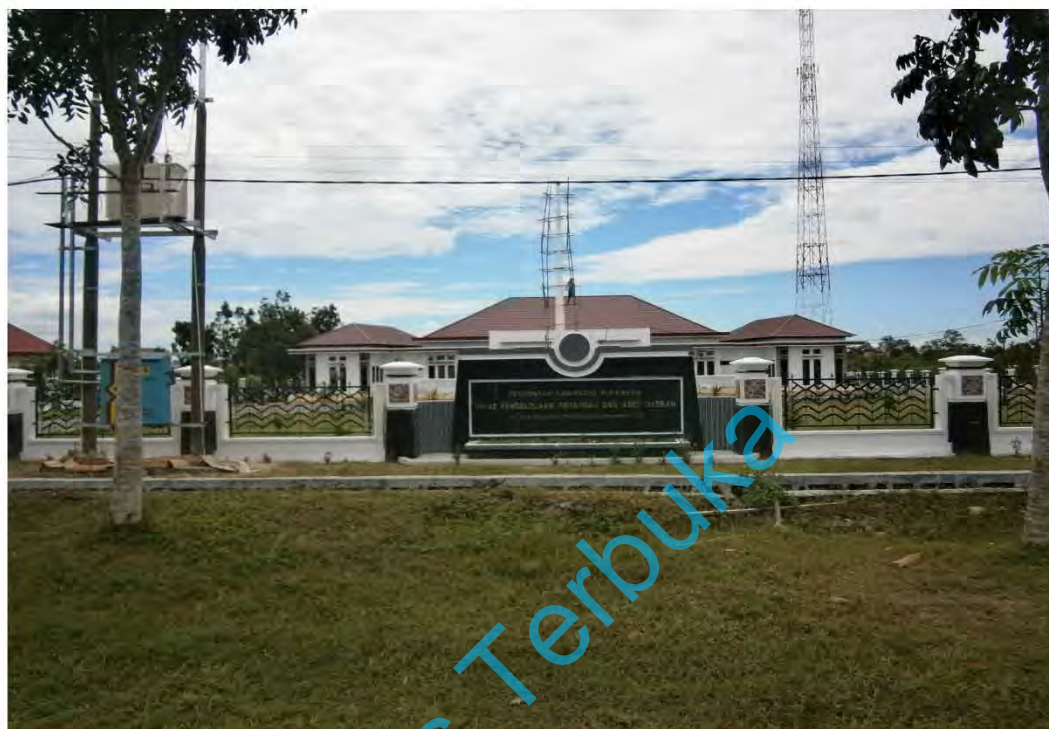
Gambar 4.2. Gedung Kantor DPKAD Kabupaten Sukamara
