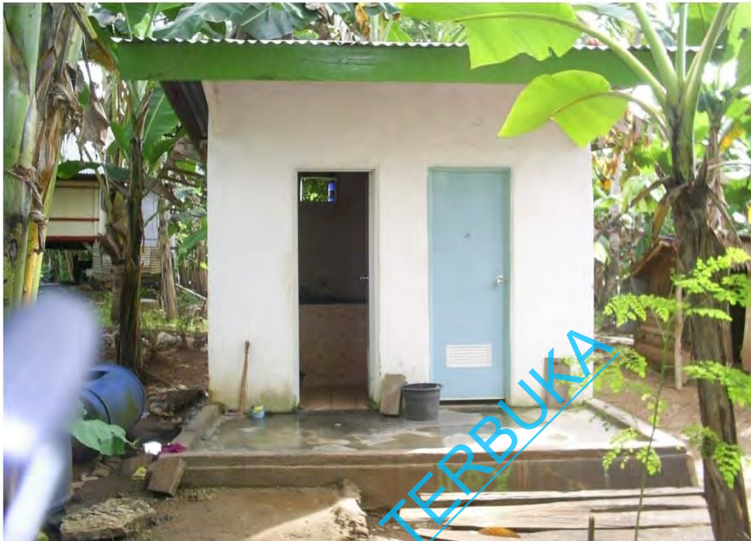
Gambar/Foto 4.8 MCK yang dibangun oleh Proyek Penanggulangan Kemiskinan di Perkotaan (P2KP) yang diperuntukan bagi warga miskin
