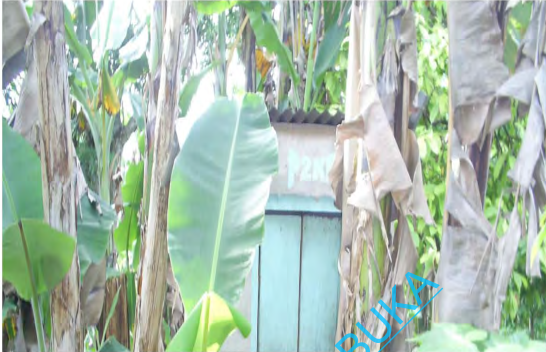
Gambar/Foto 4.9 MCK yang dibangun oleh Proyek Penanggulangan Kemiskinan di Perkotaan (P2KP) yang diperuntukan bagi warga miskin namun letaknya tidak tepat.
