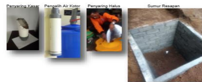
Gambar 1 Gambar IPAH (Instalasi Pemanfaatan Air Hujan) beserta komponen dan Lubang Sumur Resapan
