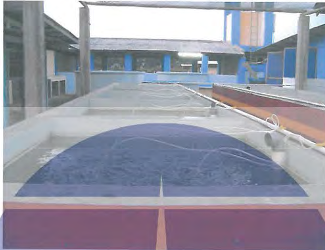
Gambar 3.1. Bak pemeliharaan/ bak uji
